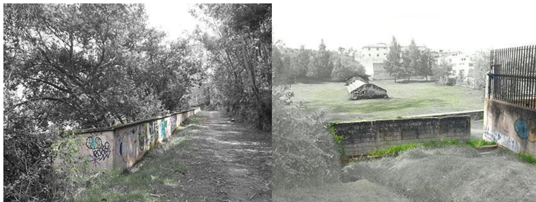
Figura 34. Vista desde el Parque Metropolitano Guanguiltagua hacia los tanques de EPMAPS y parque vecinal cercado (Suárez A., 2017)
