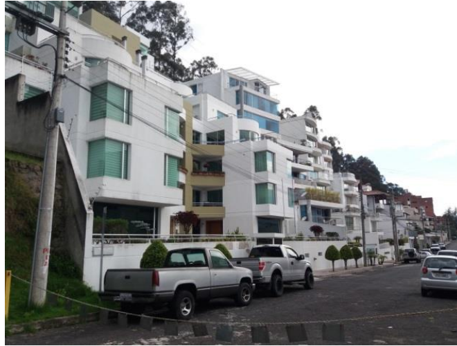
Figura 31. Edificios del borde norte del parque (Suárez A., 2017)
