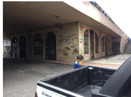
Fotografía 4: Paso desnivel Av. Pichincha
