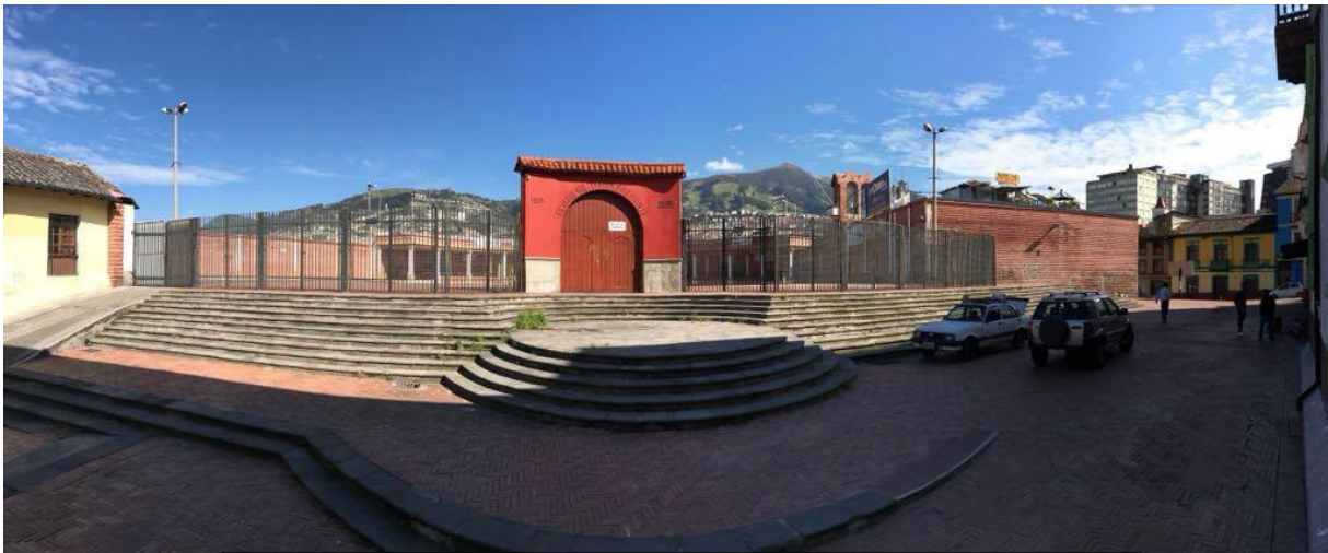
Fotografía 21: Fachada Lateral, Plaza Belmonte Calle Antepara
