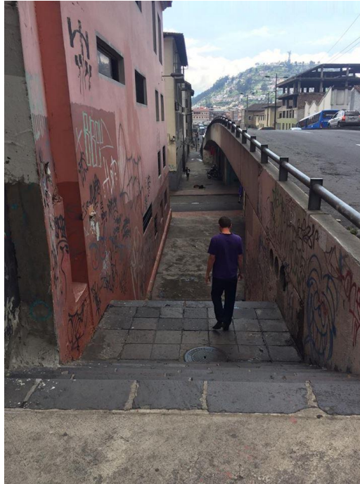
Fotografía 10. Graderío Desnivel Av. Pichincha
