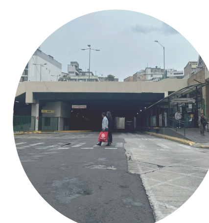
PASO DESNIVEL MANUEL LARREA
