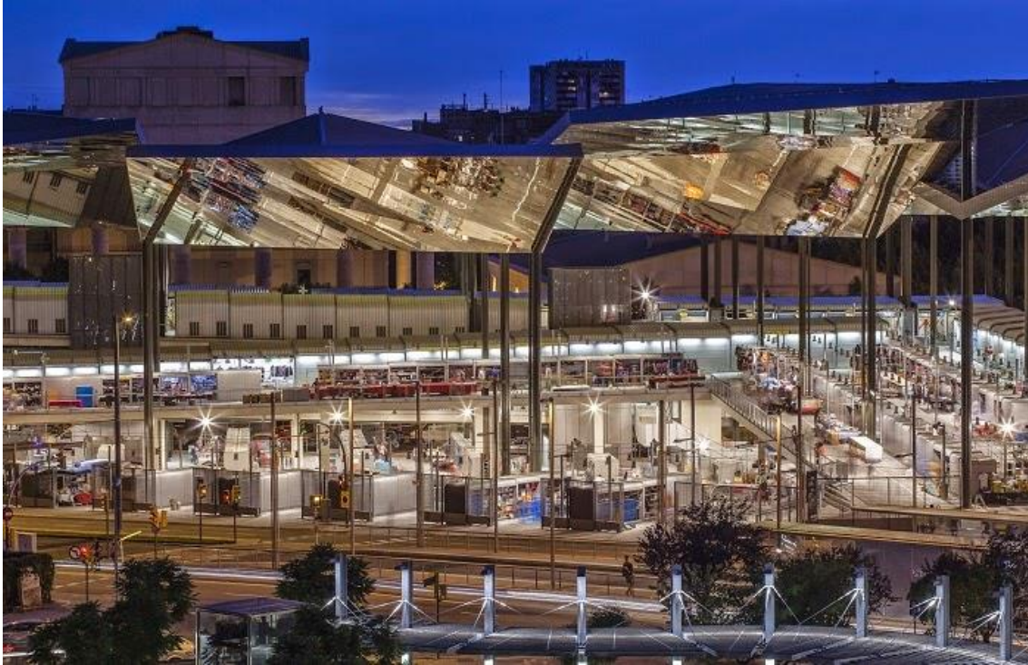
Ilustración 7: Vista de los planos inclinados
