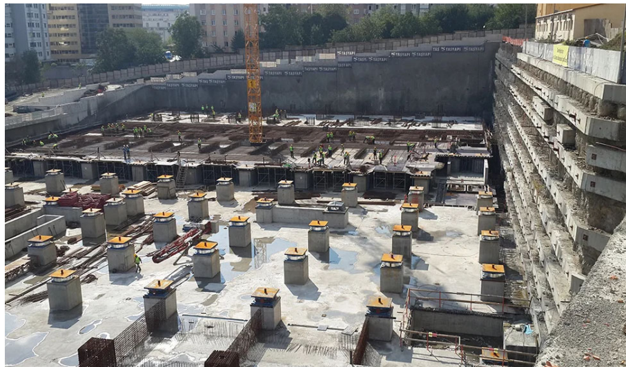
Figura 19. Ubicación en planta de aisladores en el Hospital Okmeydani and Goztepe, Turquía. (Protection, 2021)
