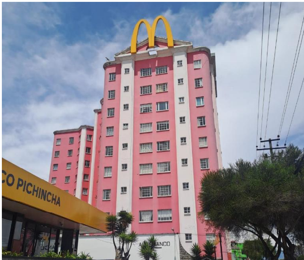
Figura 19: Edificio 9 pisos Av. De la Prensa
