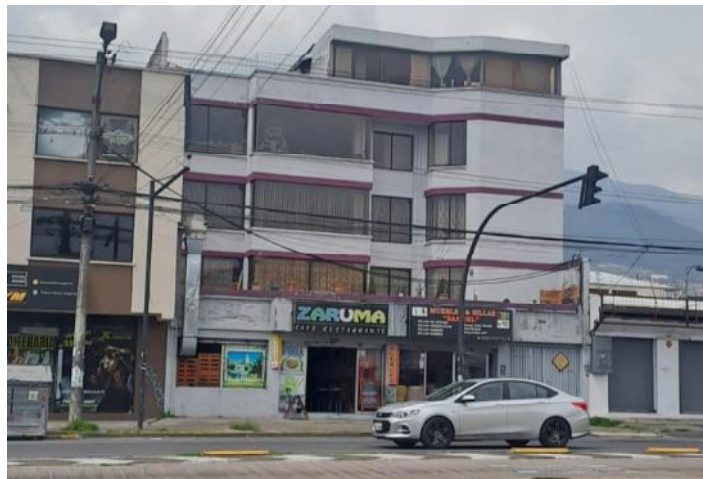
Figura 18: Edificio 4 pisos estructura regular Av. De la Prensa
