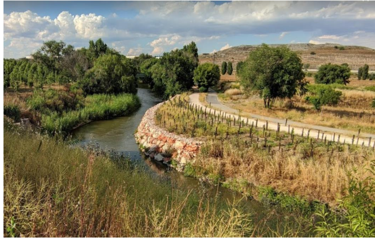
Figura 18 Tramo 2 Parque lineal del Manzanares
