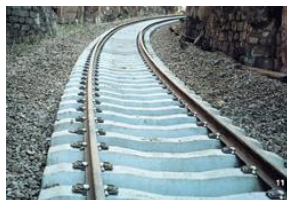
Ilustración 2.15 LINEA FÉRREA DE DURMIENTES DE HORMIGÓN Fuente: Informe Final Fiscalización Hidroplan-Ica
