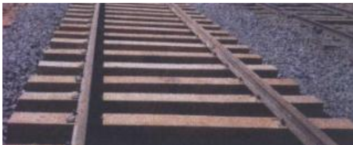
Ilustración 2.10 VIA FERREA PARA UN FERROCARRIL CON DURMIENTES DE MADERA Fuente: Informe Final Fiscalización Hidroplan-Ica
