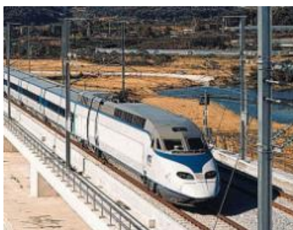
Ilustración 2.27 LOCOMOTORA ELECTRICA Fuente: Informe Final Fiscalización Hidroplan-Ica
