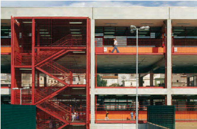
Detalle del bloque (circulaciones) Imagen: Nelson Kon.
