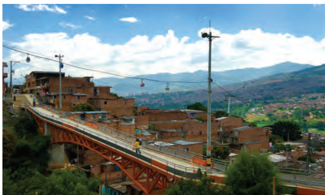
Puente Mirador Andalucía. ► Imagen: Diana Moreno.
