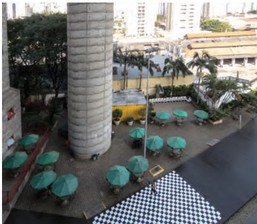
◀ Tanque de agua y deck. Imagen: Ingrid Quintana.
