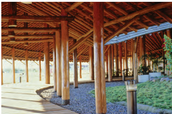
◀ Vista de corredor y cubierta Imagen: Hugo Sewaga.
