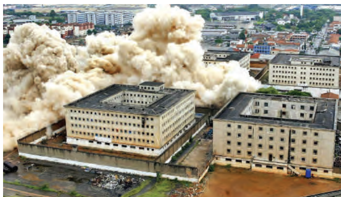
◀ Penitenciaria de Carandiru, antes de su demolición. Imagen: Lusa.
