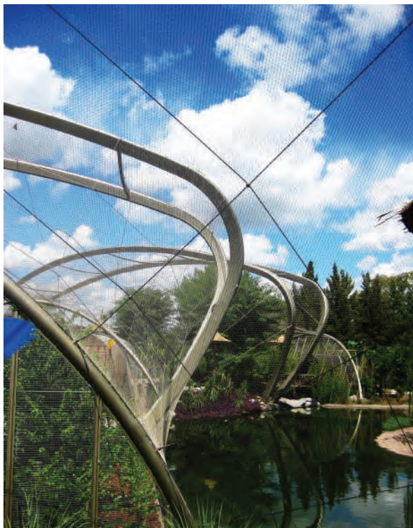
Detalle invernadero, ◀ Imagen: Hampton-Rivoira arquitectos.
