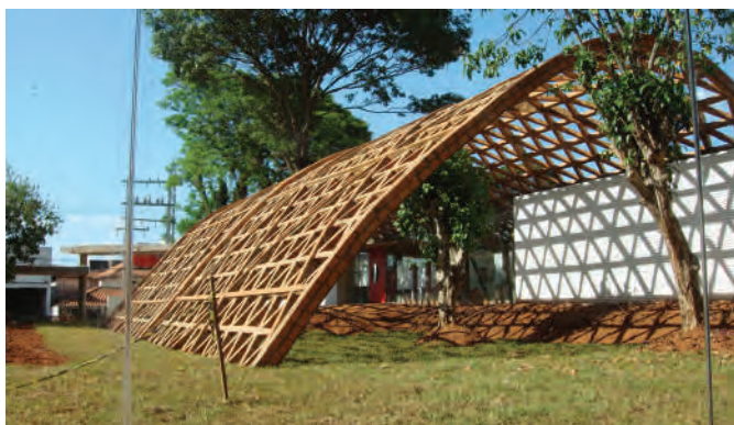
Bóveda del espacio de acceso. Imagen: Gabinete de Arquitectura. ►
