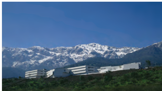
Edificio de pregrados, en el paisaje. ► Imagen: Oficina José Cruz O.
