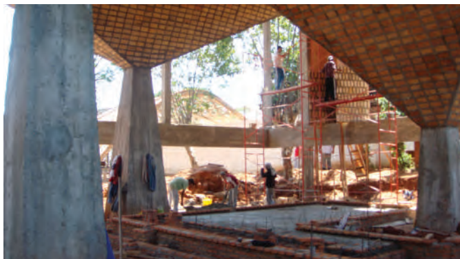
Sala de hidroterapia. Imagen: Gabinete de Arquitectura. ►
