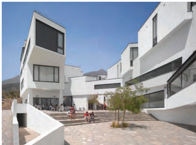
Vista exterior de los talleres. ► Imagen: Oficina José Cruz O.
