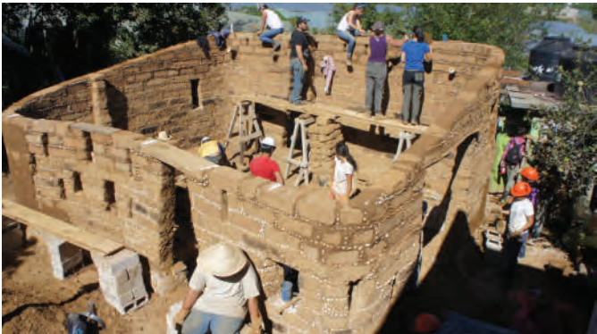
Proceso constructivo. ▶ Imagen: Juan Carlos Loyo.
