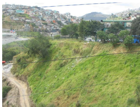
Taludes de El Censo
