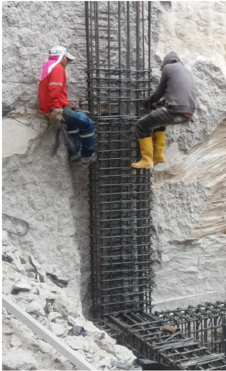
RIESGOS EN ETAPAS: 21 ARMADO DE ACERO REFUERZO VERTICAL NIVEL 0+00
