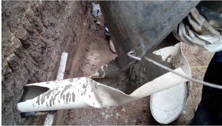
ILUSTRACIÓN 5 COLOCACIÓN DEL ANCLAJE Y VACIADO DEL HORMIGÓN
