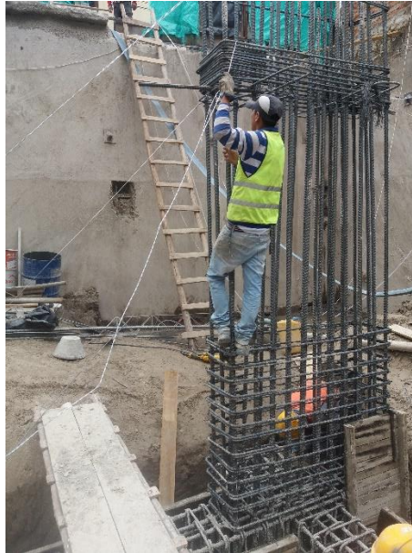
ILUSTRACIÓN 21 NIVELACIÓN DE COLUMNAS O MUROS
