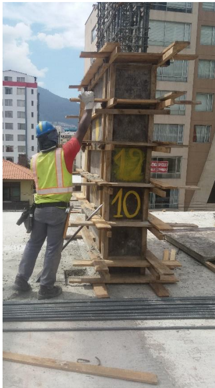
RIESGOS EN ETAPAS: 24 ENCOFRADO Y FUNDICIÓN DE COLUMNAS
