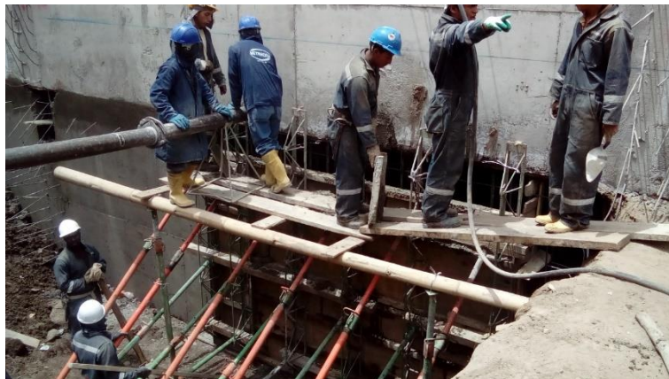
RIESGOS EN ETAPAS: 9 FUNDICIÓN DE PANTALLAS.
