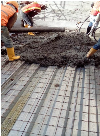
RIESGOS EN ETAPAS: 31 FUNDICIÓN DE LOSA Y VIGAS
