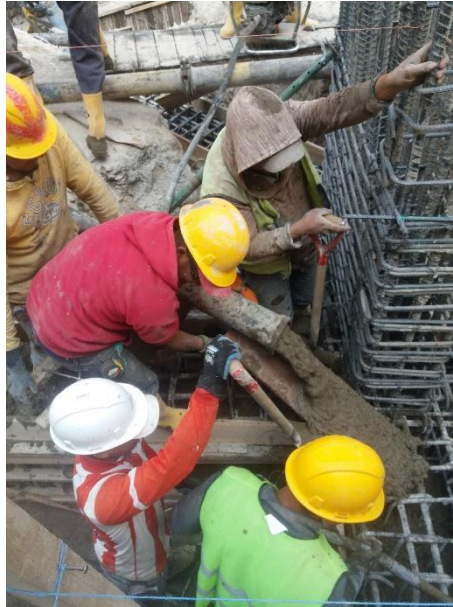
ILUSTRACIÓN 18 FUNDICIÓN DEL ALMA DE LA VIGA
