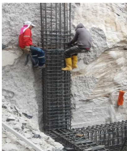
ILUSTRACIÓN 20 COLOCACIÓN DE ACERO DE CONFINAMIENTO ESTRIBOS
