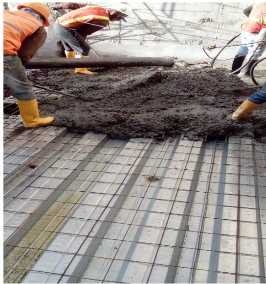
ILUSTRACIÓN 27 FUNDICIÓN DE LOSA
