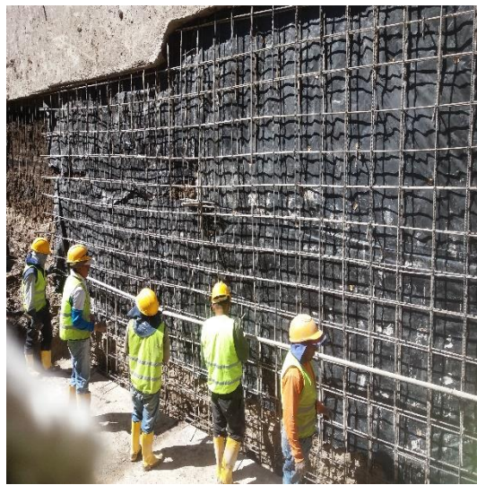
ILUSTRACIÓN 6 ARMADURA DE REFUERZO DEL MURO
