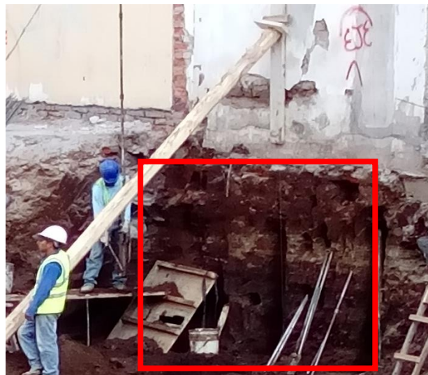
ILUSTRACIÓN 2 ÁREA DEL MURO
