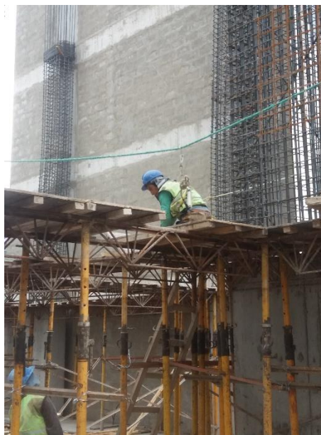
ILUSTRACIÓN 24 ENCOFRADO DE PARA VIGAS
