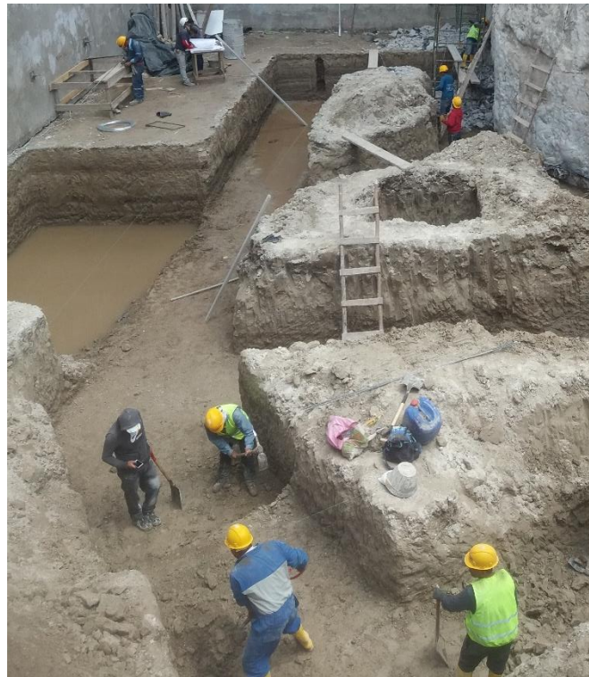
RIESGOS EN ETAPAS: 13 APERTURA DE ZANJAS
