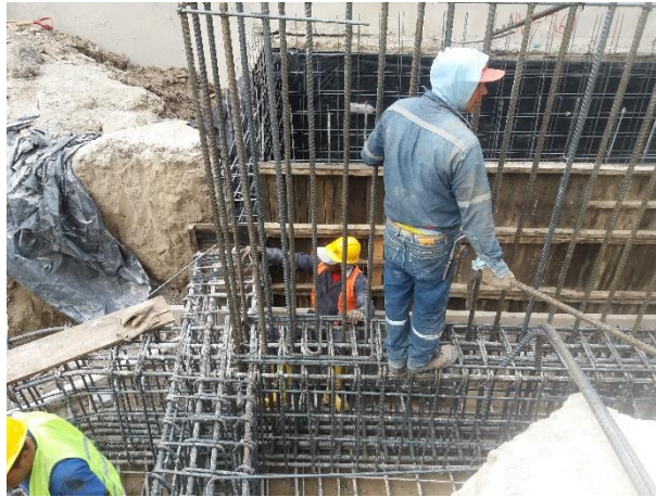
ILUSTRACIÓN 19 ARMADO DE ACERO DE REFUERZO LONGITUDINAL MUROS
