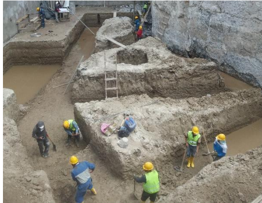
ILUSTRACIÓN 11 APERTURA DE ZANJAS
