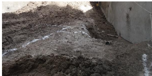
ILUSTRACIÓN 10 MARCADO DEL ÁREA DE CORTE DEL SUELO.
