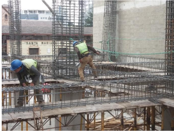
ILUSTRACIÓN 25 ARMADO DE ACERO ESTRUCTURAL
