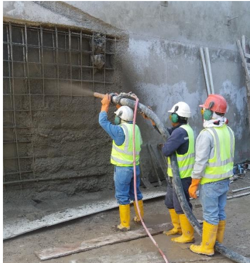
ILUSTRACIÓN 9 FUNDICIÓN MEDIANTE HORMIGÓN PROYECTADO
