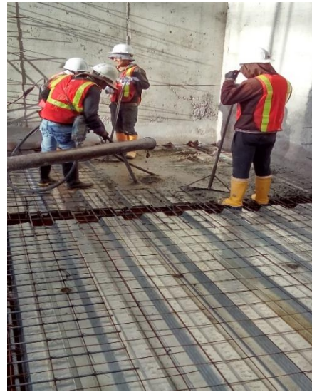
RIESGOS EN ETAPAS: 31 FUNDICIÓN DE LOSA Y VIGAS
