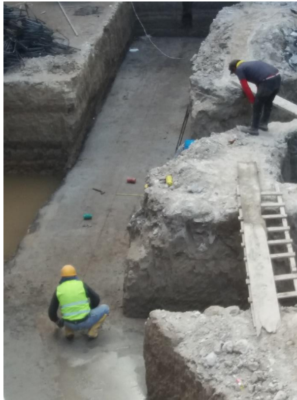
RIESGOS EN ETAPAS: 15 FUNDICIÓN DE REPLANTILLO Y TIMBRADO DE EJES.
