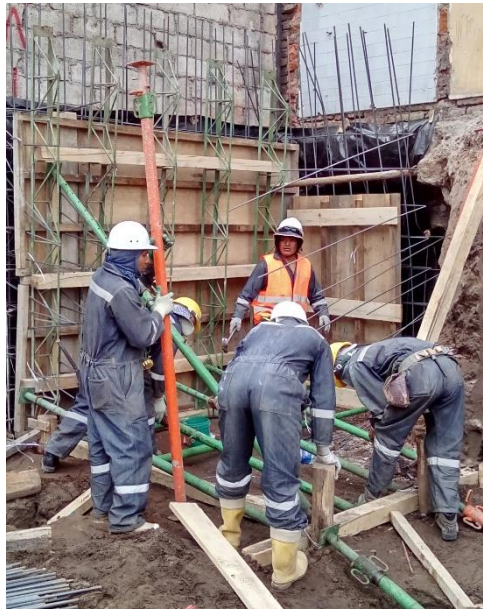
ILUSTRACIÓN 7 ENCOFRADO DE MURO
