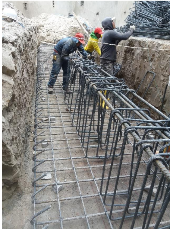
RIESGOS EN ETAPAS: 17 COLOCACIÓN DE ARMADURA DE REFUERZO EN CIMENTACIÓN.
