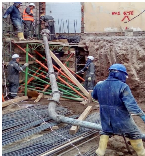
ILUSTRACIÓN 8 FUNDICIÓN DEL MURO MÉTODO TRADICIONAL
