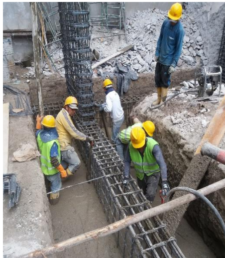
ILUSTRACIÓN 17 FUNDICIÓN ZAPATA
