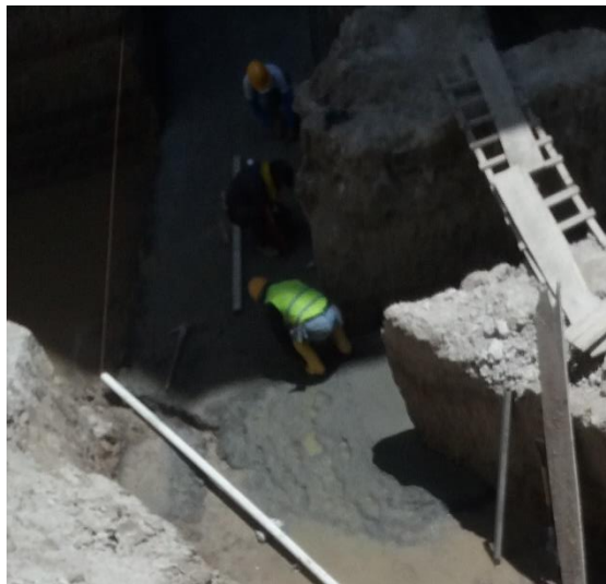
ILUSTRACIÓN 12 FUNDICIÓN DE REPLANTILLO.
