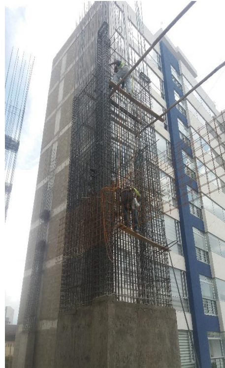
RIESGOS EN ETAPAS: 22 ARMADO DE ACERO DE REFUERZO VERTICAL NIVEL 15 METROS
