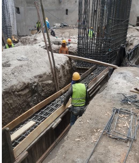
ILUSTRACIÓN 16 ENCOFRADO DEL ALMA
