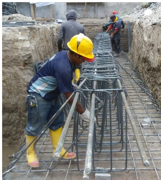
ILUSTRACIÓN 14 ARMADO DE REFUERZO DE LA CIMENTACIÓN.
