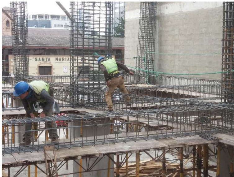
RIESGOS EN ETAPAS: 29 ARMADO DE ACERO DE REFUERZO DEN VIGAS
