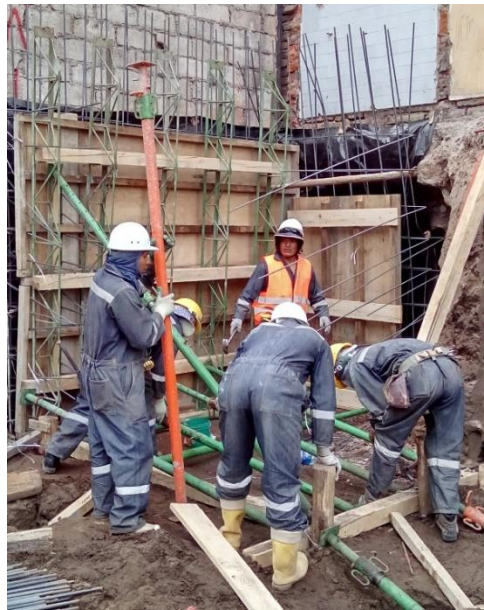
RIESGOS EN ETAPAS: 7 ENCOFRADO Y DESENCOFRADO.
