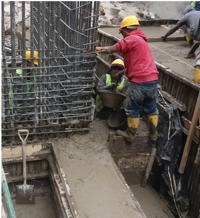
RIESGOS EN ETAPAS: 19 ENCOFRADO Y FUNDICIÓN DE LA CIMENTACIÓN.
