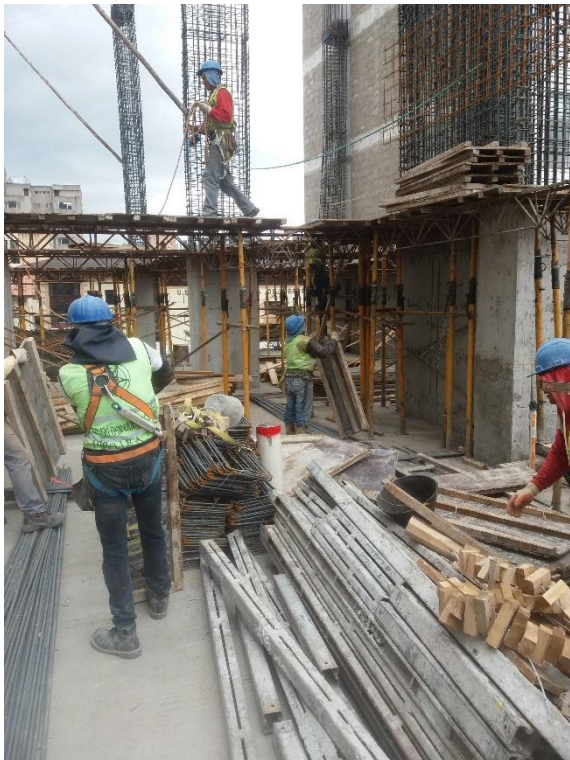
RIESGOS EN ETAPAS: 26 ENCOFRADO INFERIOR PARA VIGAS
