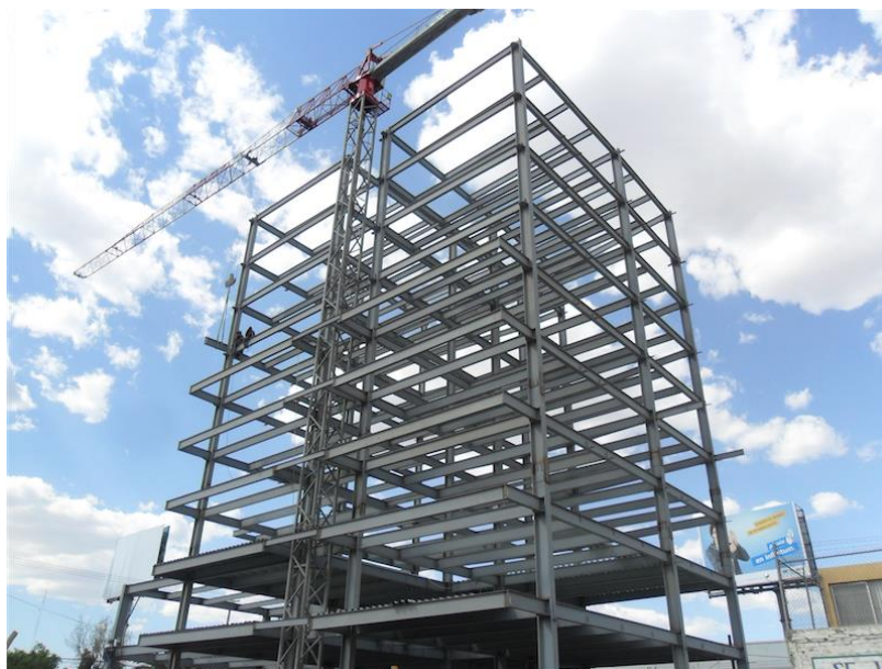
Figura 1. Vista general de un edificio de estructura de acero
