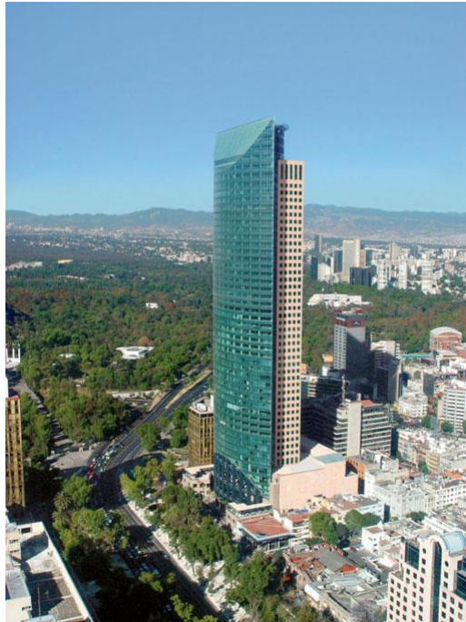
Figura 111. Torre Mayor ubicada en México D.F.
