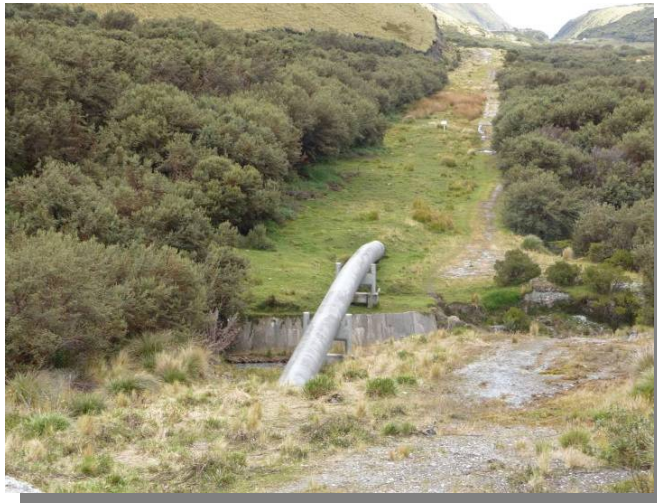
Fotografía 4. Paso elevado quebrada Carihuaycu aguas arriba
