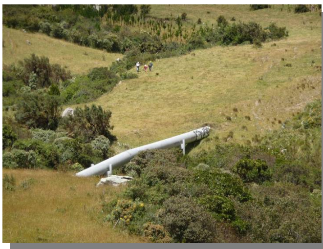
Fotografía 5. Paso elevado quebrada Carihuaycu aguas abajo
