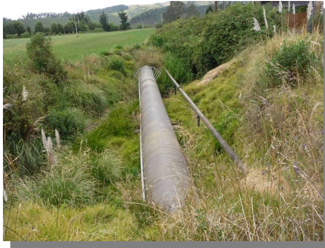
Fotografía 8. Paso elevado quebrada Corazón aguas abajo
