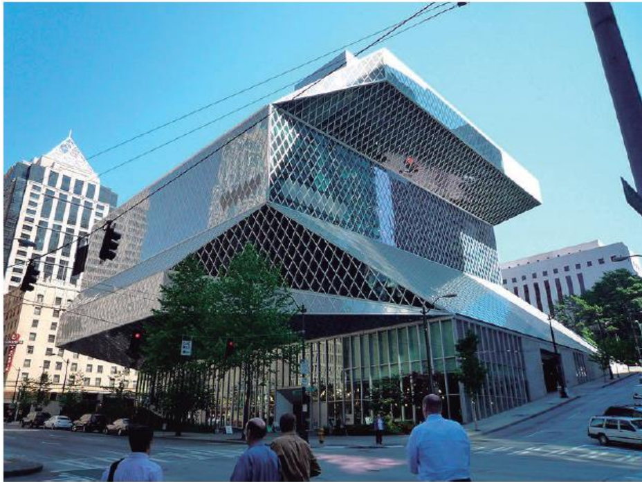
Vista exterior del edificio
