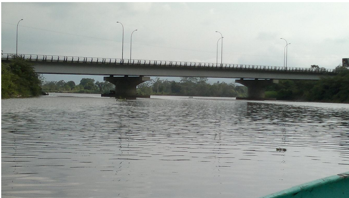
Puente sobre el Rio Esmeraldas
