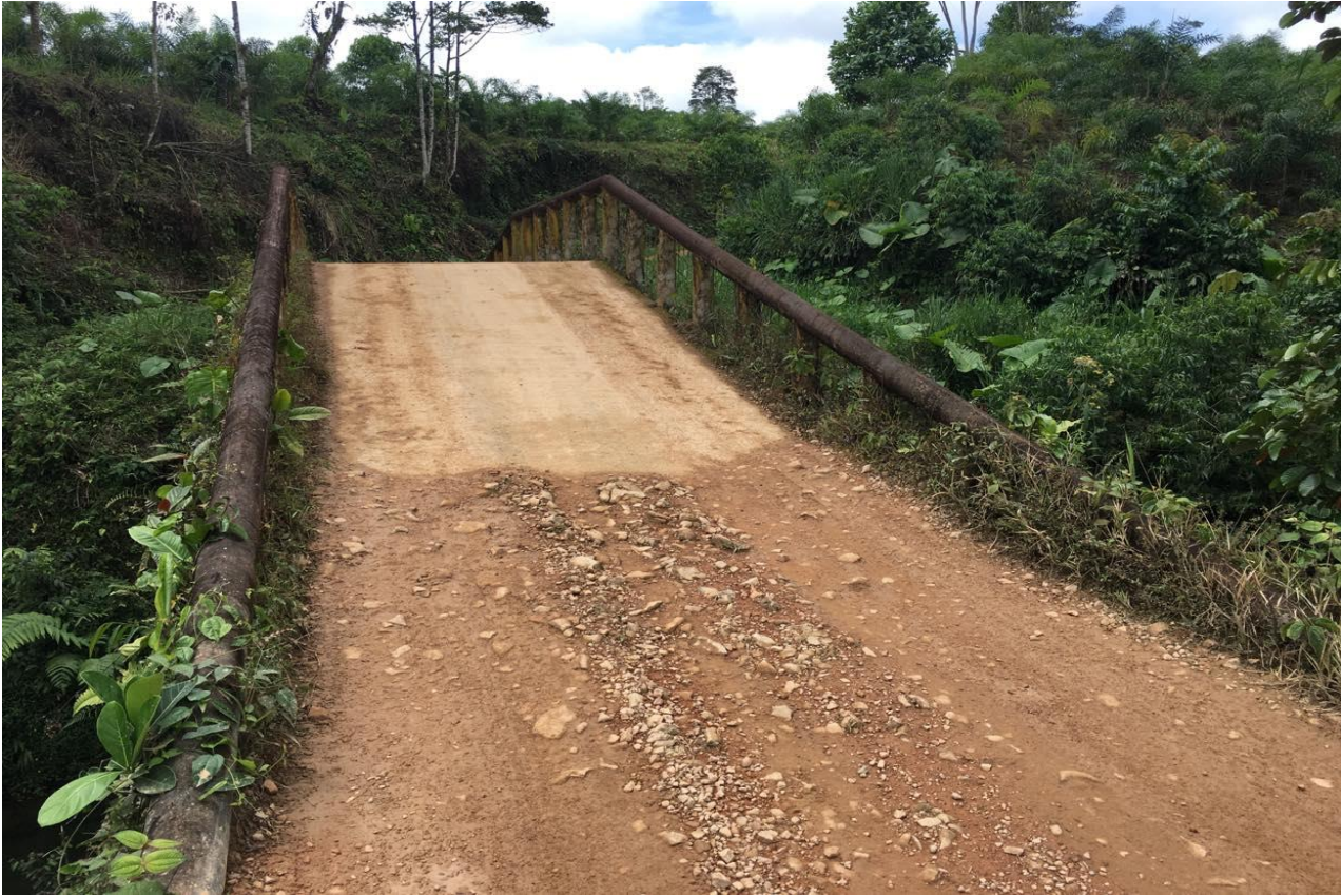
Anexo 45: Puente FID 36 PVM
