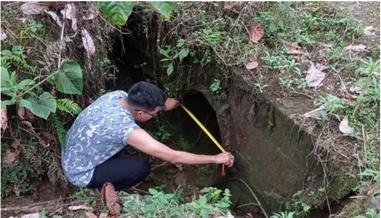
Anexo 23: Alcantarilla FID 22 PVM
