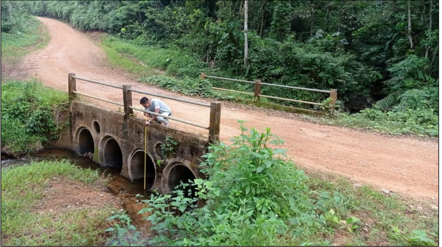
Anexo 22: Alcantarilla FID 5 PVM
