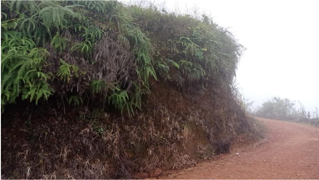
Anexo 67: Talud FID 3 PVM
