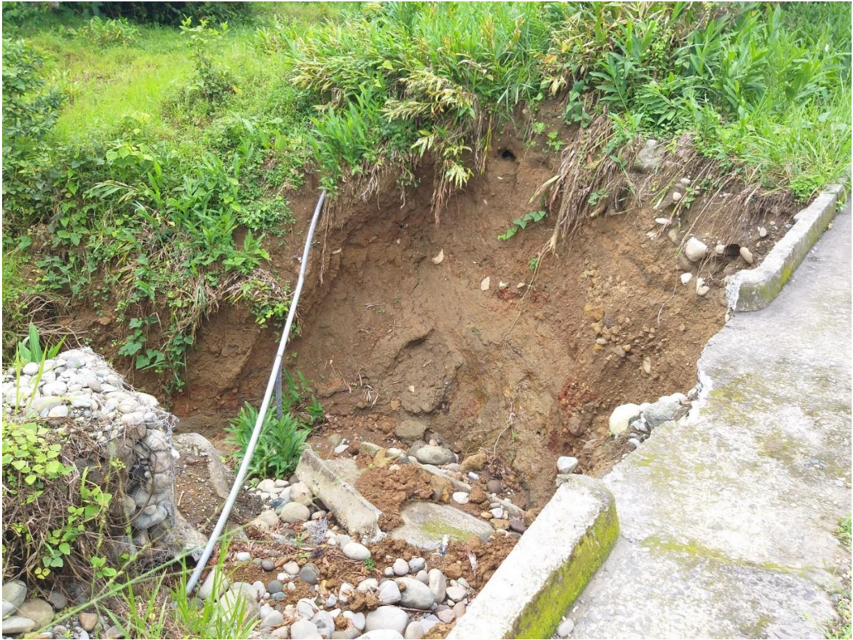
Anexo 32: Alcantarilla FID 24 SMDB
