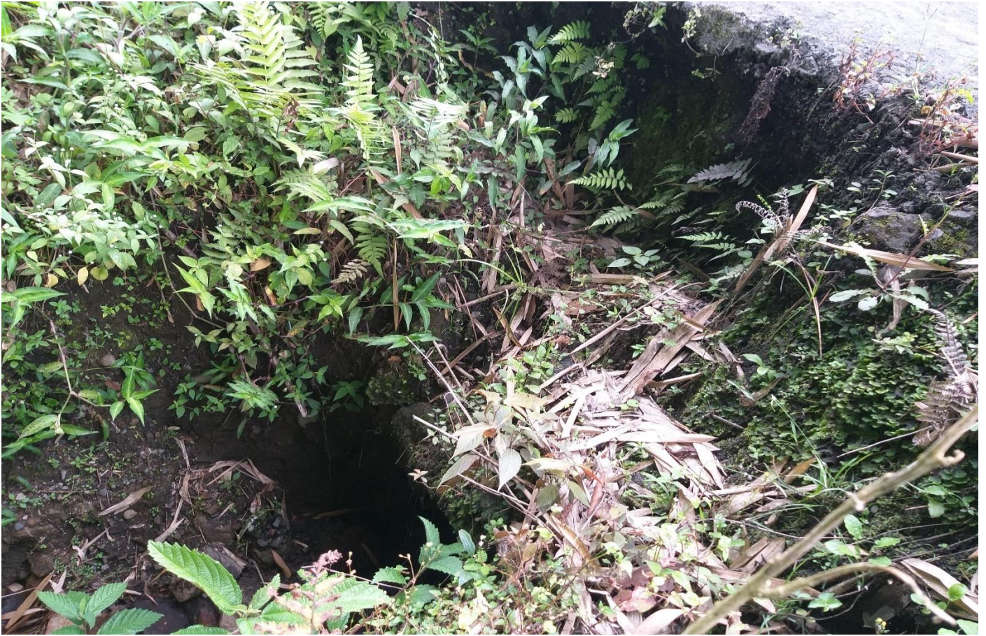
Anexo 30: Alcantarilla FID 105 SMDB
