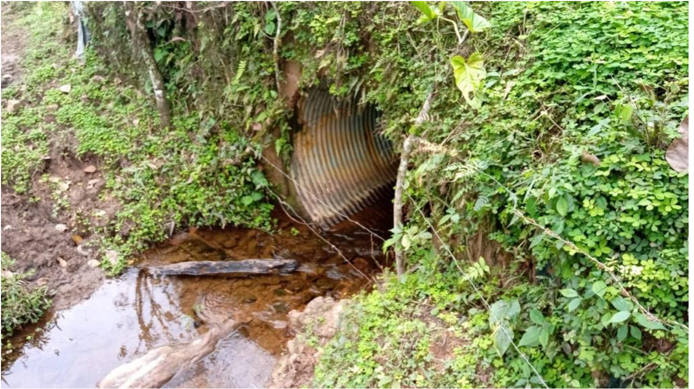
Anexo 26: Alcantarilla FID 40 PVM
