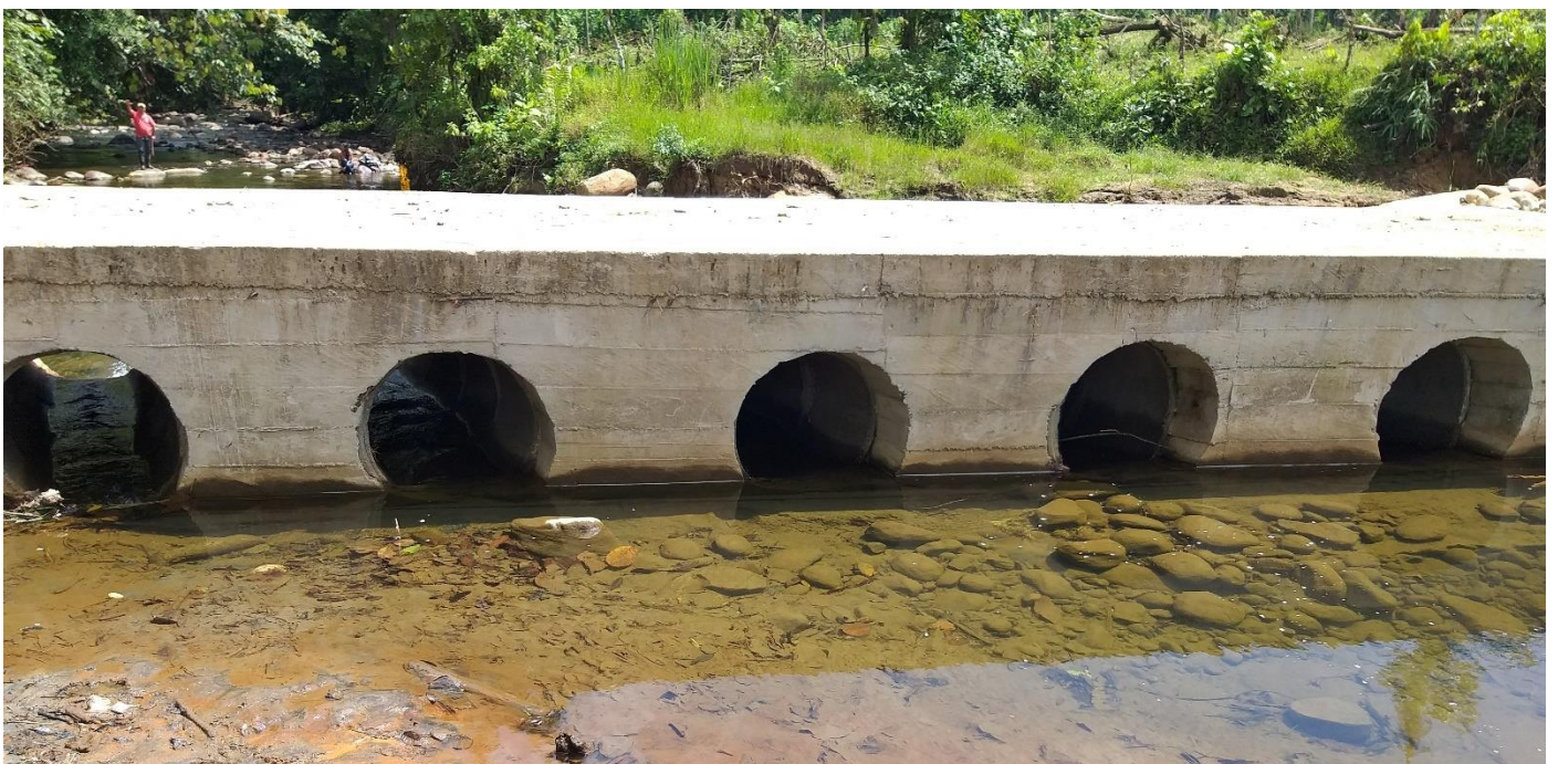
Anexo 31: Alcantarilla FID 128 SMDB
