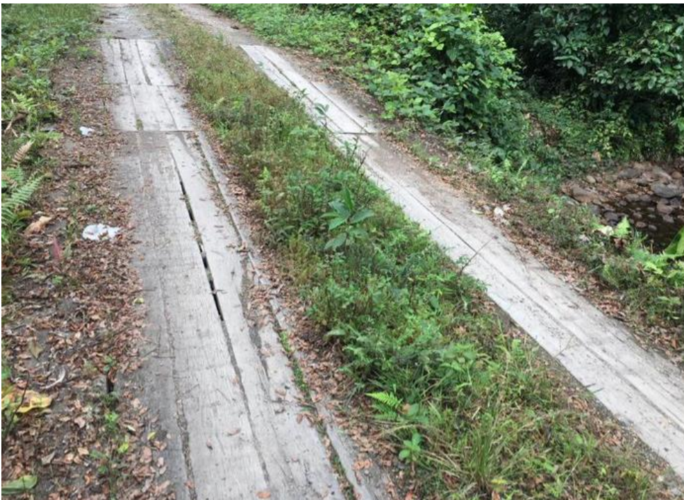
Anexo 43: Puente FID 38 PVM
