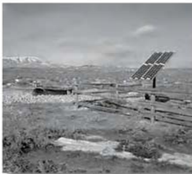
Sistema de bombeo SQ Rex para abrevaderos de ganado
