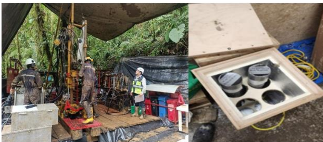
Figura 21.- Máquina de perforación y muestras de Shelby.
