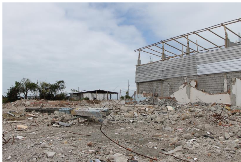
Ilustración 2: Construcción colapsada por el sismo del 16 de abril del 2016.
