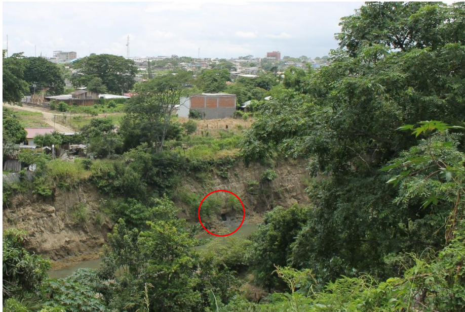
Ilustración 24: Evidencia de punto de descarga de red de alcantarillado en el río Tachina
