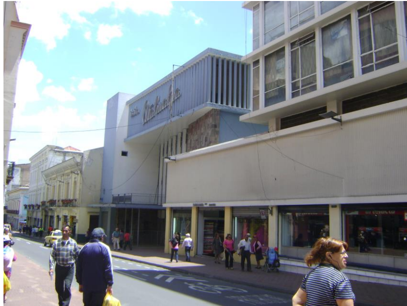
Fuente: Calle Venezuela: Torre B: comercio en planta baja, Propia. 2014
