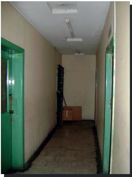
Fuente: Pasillo Nivel 2, Torre B: Propia. 2014.
