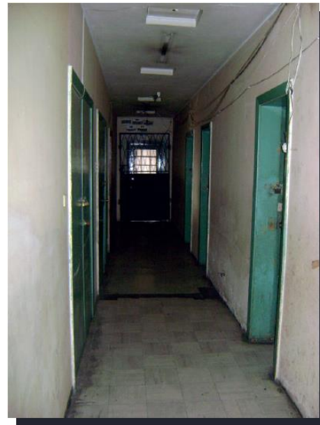
Fuente: Pasillo nivel 3: Torre B: Propia. 2014
