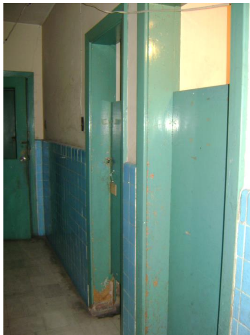
Fuente: Ingreso a las áreas individuales: Torre B: Propia. 2014
