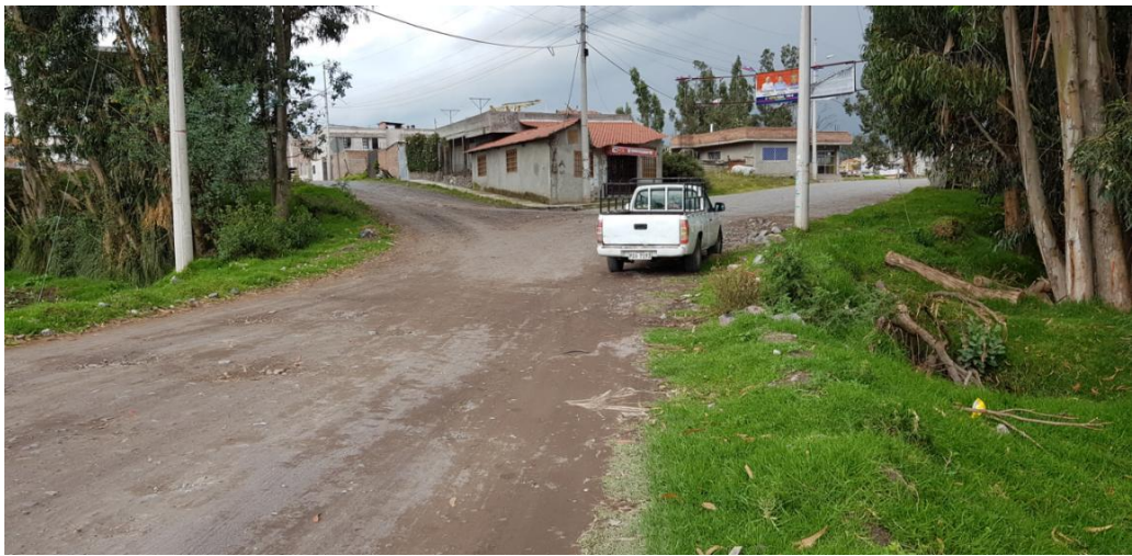
Imagen 18: Nodo 10 sobre el puente (Autor, 2023)
