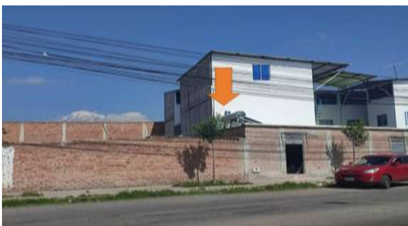
Registro fotográfico 2. Calefón panamericana Riobamba-Guano
