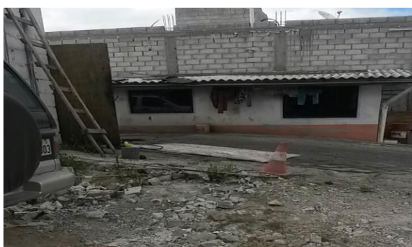
Fotografía 35 . Lavadora y Lubricadora M y S Elaboración propia, 2016.
