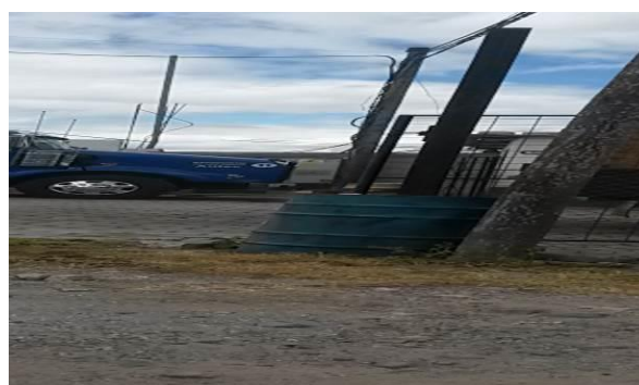
Fotografía 36. Lavadora y Lubricadora M y S Elaboración propia, 2016.
