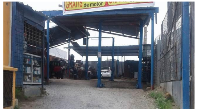
Fotografía 22. Mecánica Automotriz 2 Elaboración propia, 2016.
