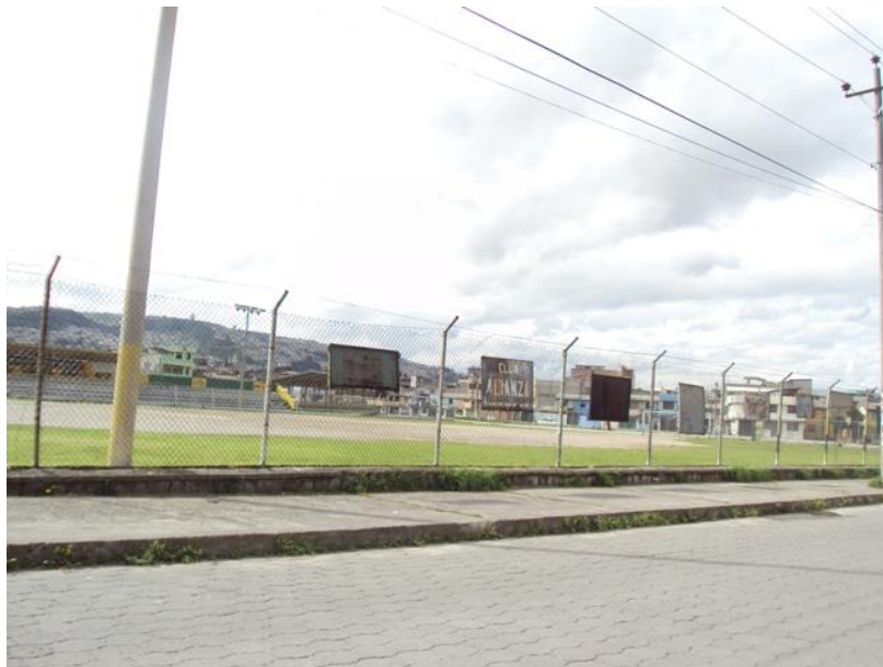
Fotografía 13: Accesibilidad - Mallas, barreras para el acceso. Santa Anita
