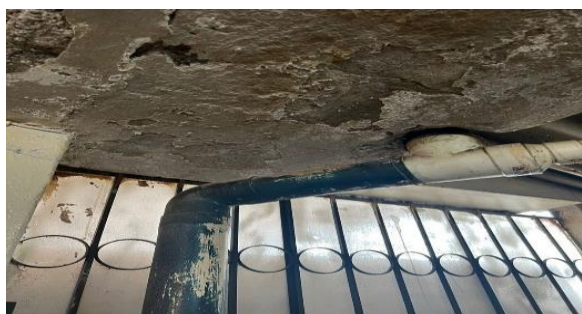
Tubería que atraviesa la losa
