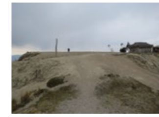
Plaza central deteriorada
