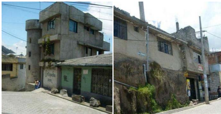
Ejemplos de construcción
