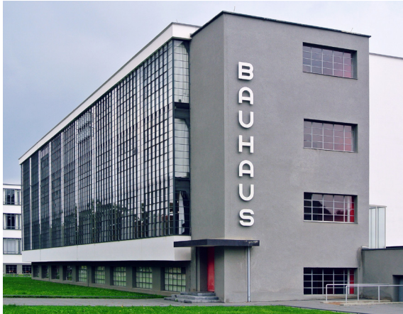
Imagen 4: Vista Escuela de la Bauhaus, Dessau, Alemania Fuente: [fotografía]. Spyrosdrakopoulos. Recuperado de https://commons.wikimedia.org/wiki/File:6265_Dessau.JPG
