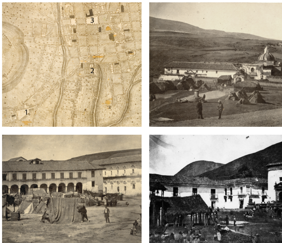
Figura 49. Plazas de La Recoleta, Santo Domingo y San Francisco en Quito luego del terremoto de 1868.
