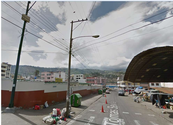
Figura 14. Tendido eléctrico y de telecomunicaciones en la calle Tomás Sevilla.
