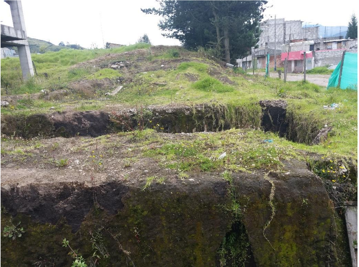
Ilustración 5. 28: Terreno natural y excavación, Manzana 14.
