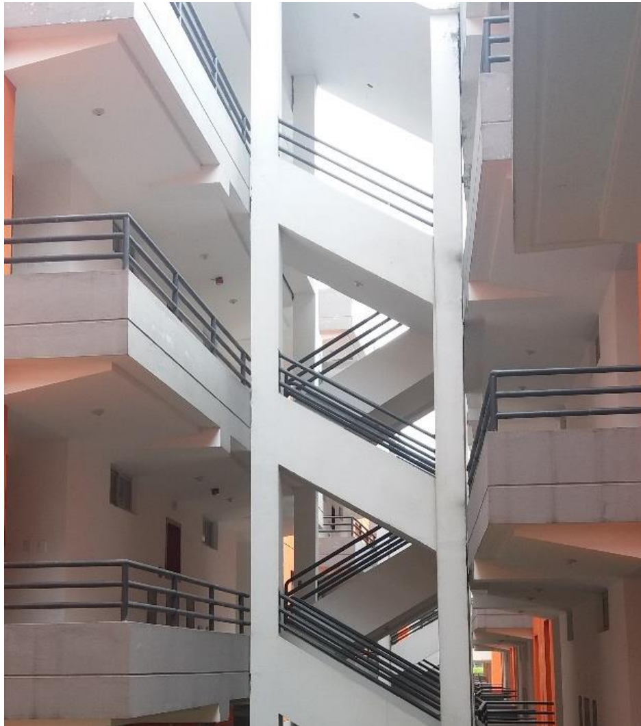
Ilustración 5. 67: Escaleras. Bloque de Relocalización.
