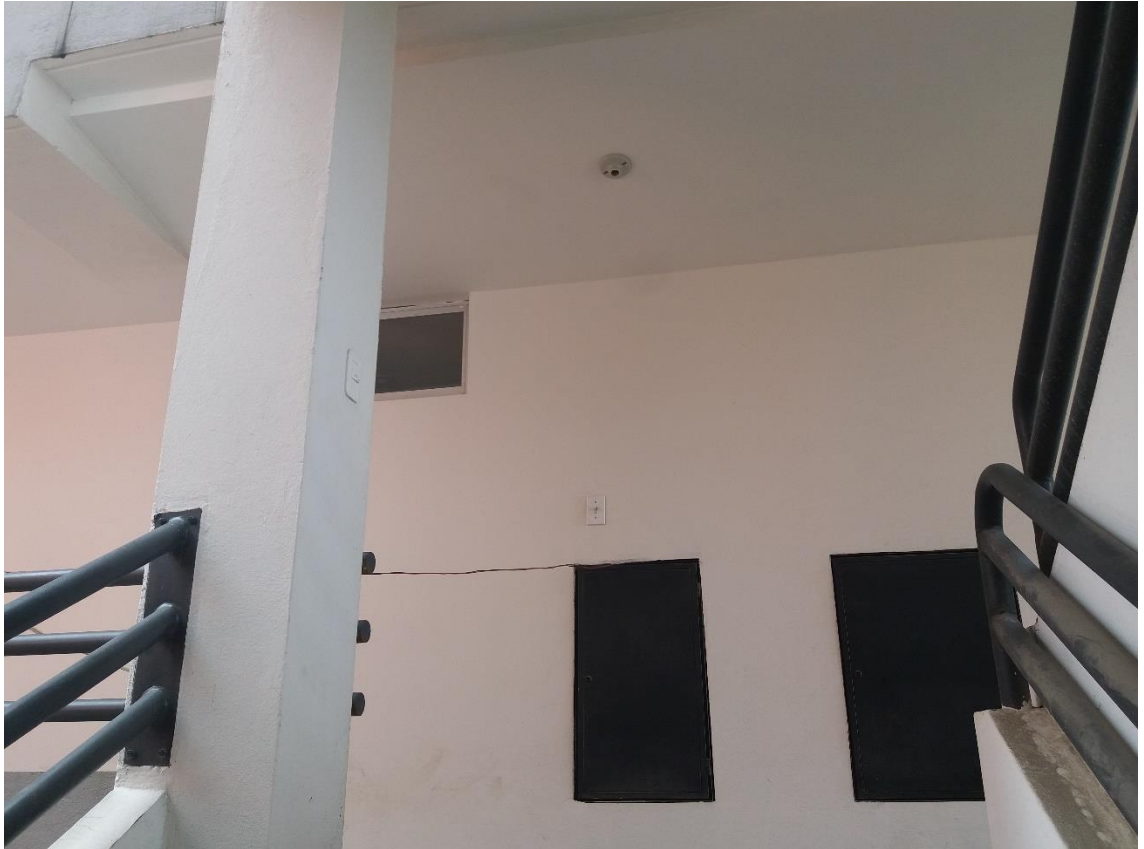
Ilustración 5. 5: Iluminación de circulaciones interiores en Bloques de Relocalización.
