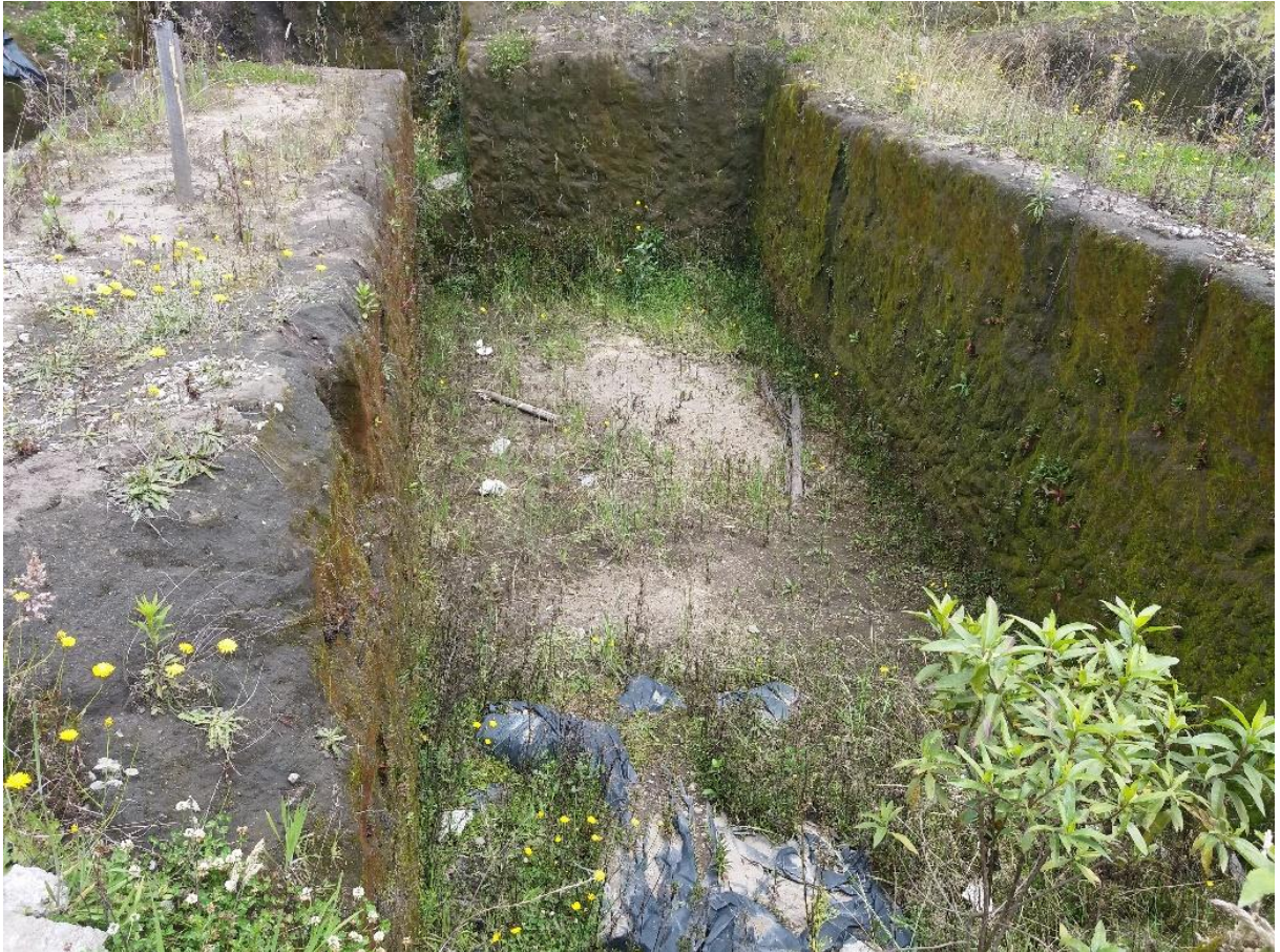
Ilustración 5. 34: Excavación para vigas de cimentación, Manzana 14.
