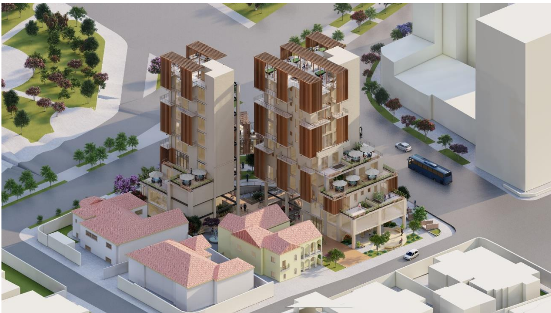
Figura 74 Vista Aérea. (Elaboración Propia, 2023)
