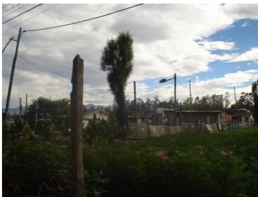
Foto 2. Estructura en proceso de consolidación en la parroquia de Puenbo
