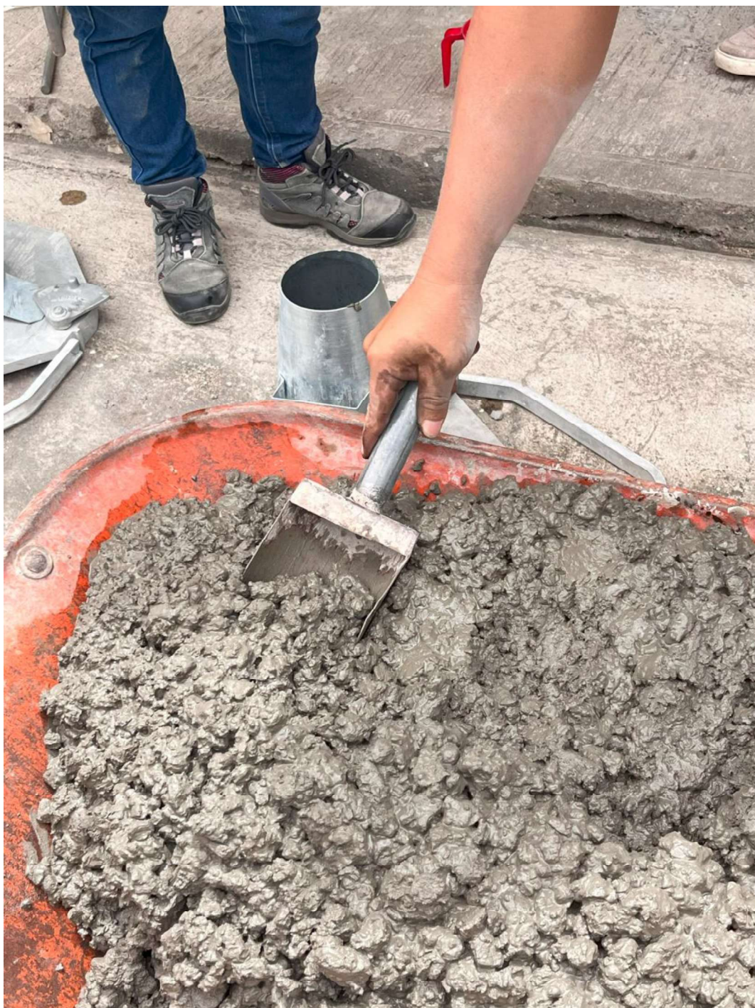
Ilustración 18. Fabricación de hormigón
