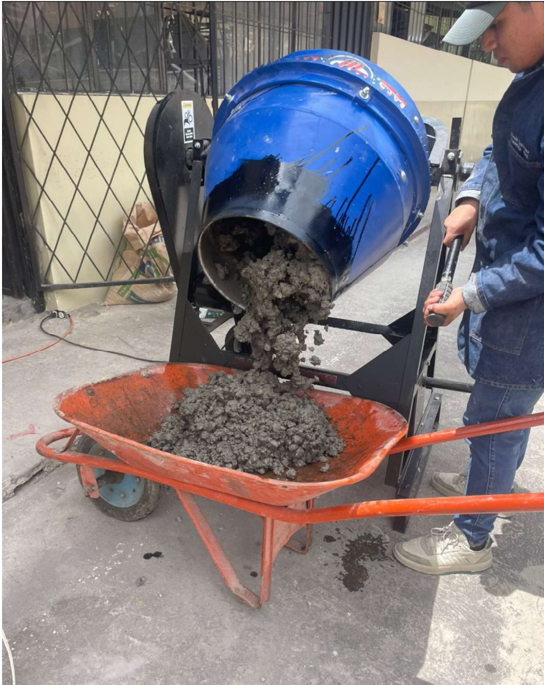
Ilustración 25. Fabricación de hormigón
