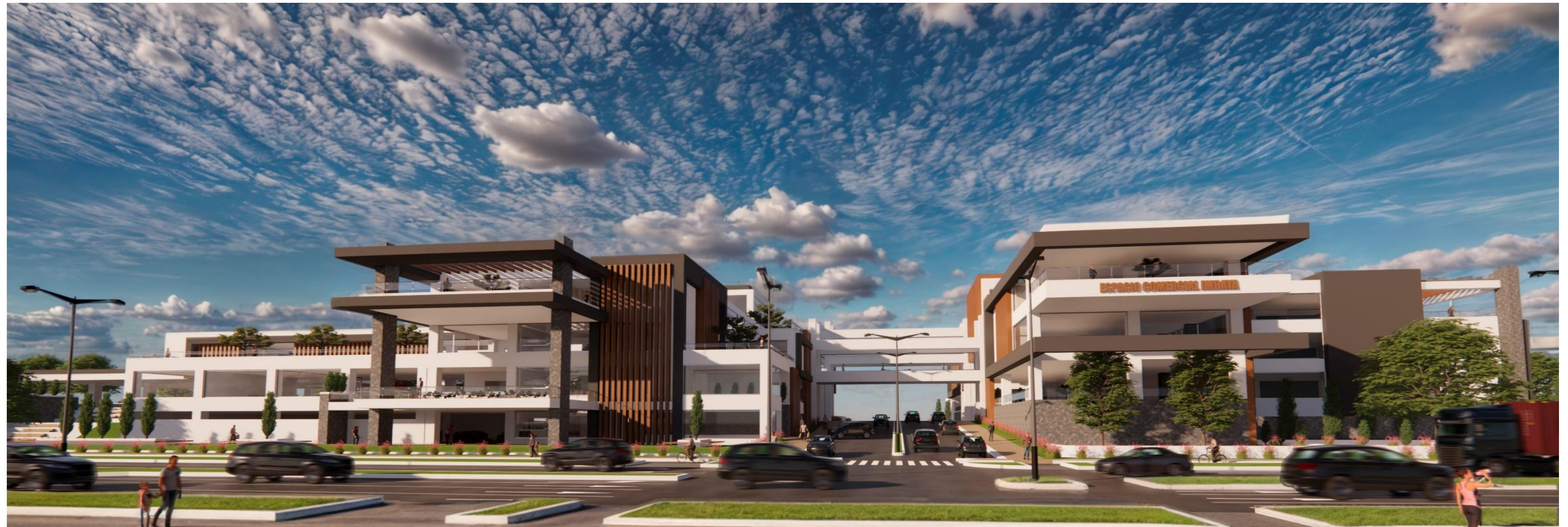
Figura 75 Espacio comercial (Fachada Principal)
