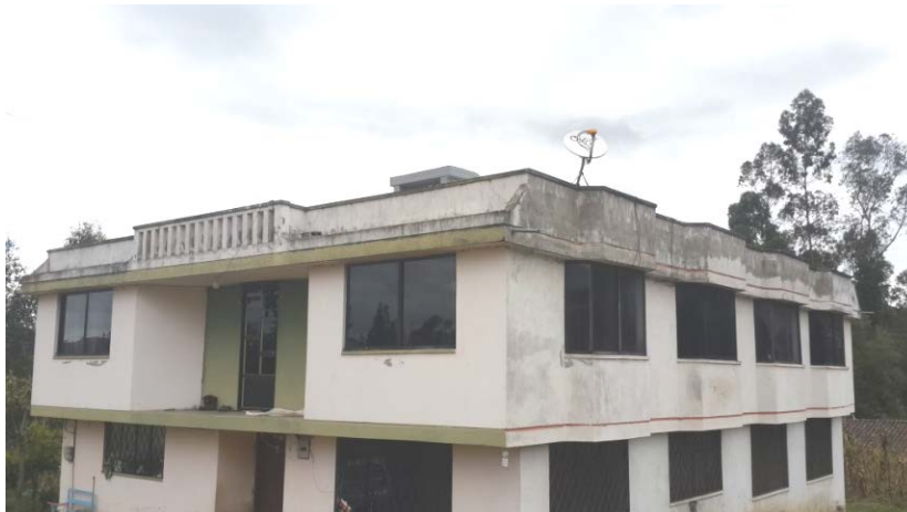
Figura 55. Fachada del domicilio
