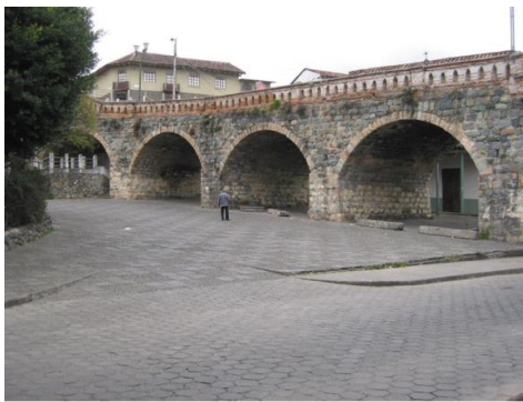
Figura 37: Puente Roto Fuente: PECHC , 2010
