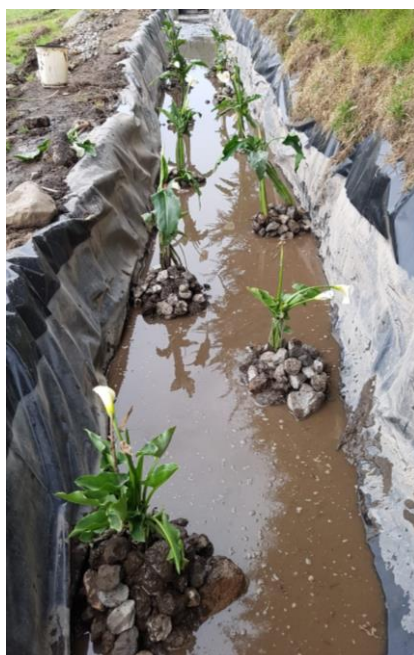
Figura 17. Plantación del cartucho en la piscina biodigestora. Elaborado por: Autor
