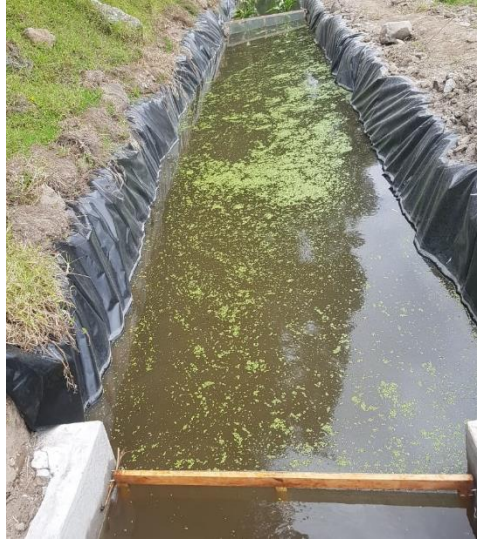
Figura 16. Colocación de la lenteja de agua en la piscina biodigestora. Elaborado por: Autor
