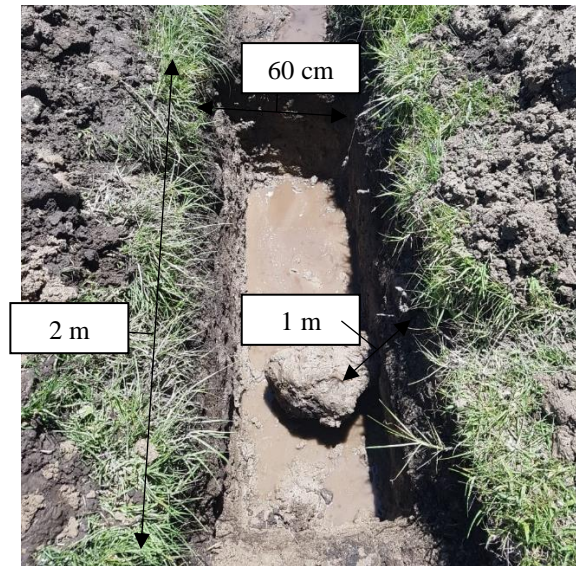
Figura 14. Medidas del desarenador. Elaborado por: Autor
