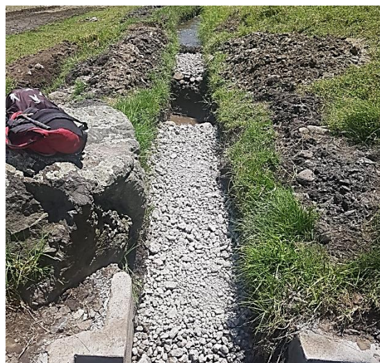
Figura 15. Colocación del cascajo en el canal de agua. Elaborado por: Autor
