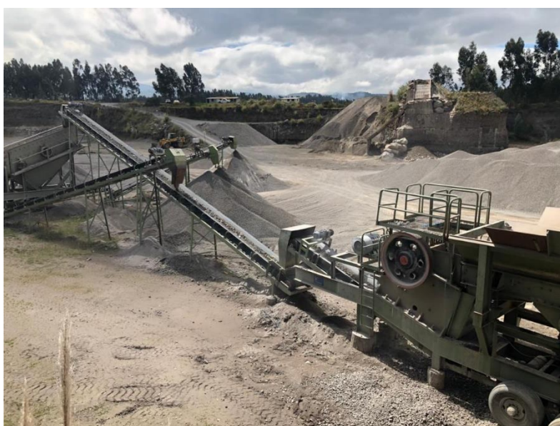
Trituradora ubicada en la mina San Joaquín.
