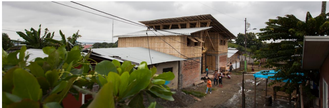
Figura 35: Centro Cultural Chamanga en Esmeraldas Fuente: (Plataforma Arquitectura, 2018)
