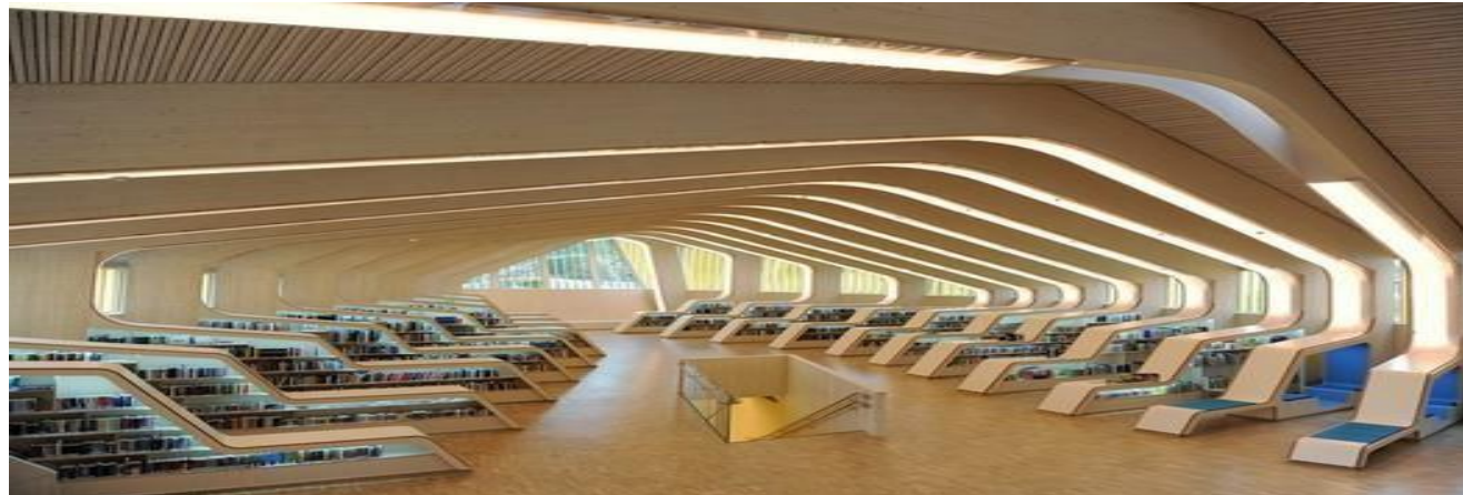
Figura 28: Madera prefabricada en techo Fuente: (Plataforma Arquitectura, 2012)
