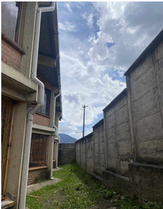
Ilustración 17. Bajantes de agua lluvia a recolectarse.
