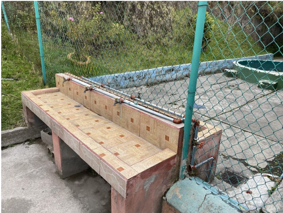
Ilustración 19. Lava manos, posible zona de aprovechamiento de agua lluvia.
