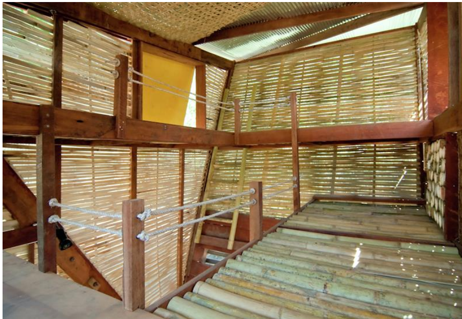
Ilustración 19 Vista interior del refugio para niños. Fuente: Plataforma arquitectura “Casa Soe Ker Tie”, Tak (Tailandia).
