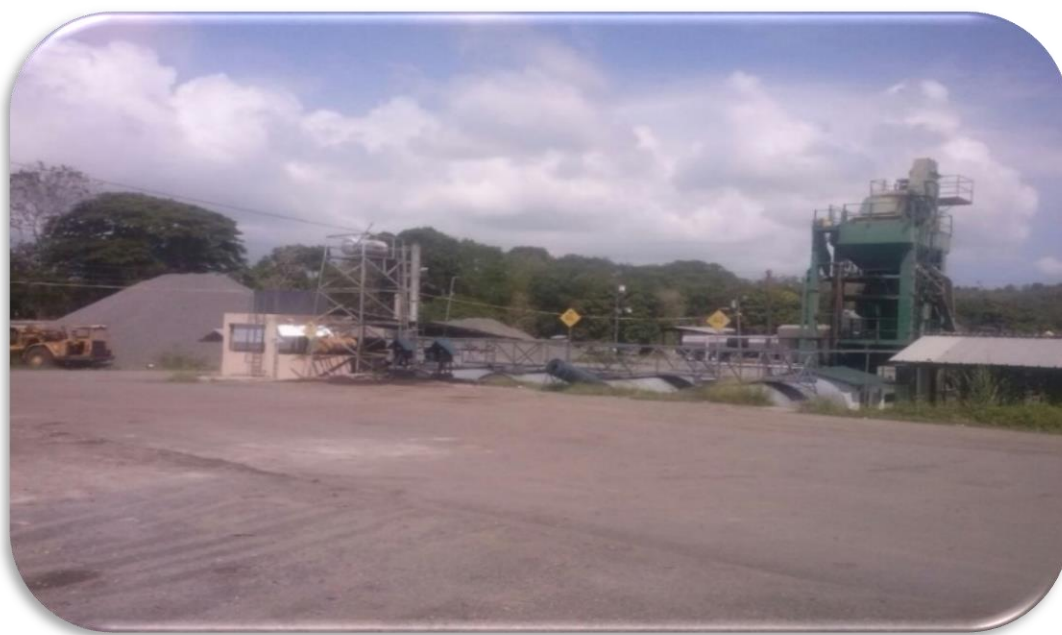
Imagen Nro. 4 Planta asfáltica del GADPE
