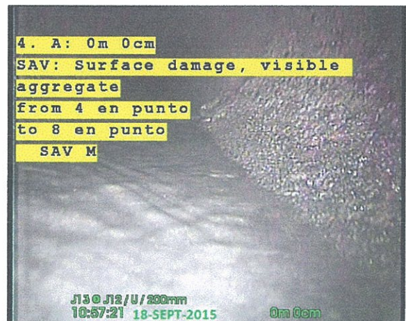
Foto: 151231_1057A-CDAJARDIN.jpg 0m, Superficie de rugosidad está aumento desconocido, para 04 a 08 en punto, within 200mm of joint: NO / Ninguna, dentro de los parámetros admisibles
