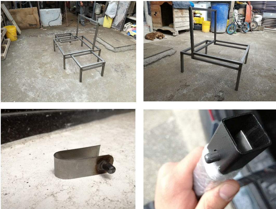
Imagen 42: proceso de construcción de estructura metálica
