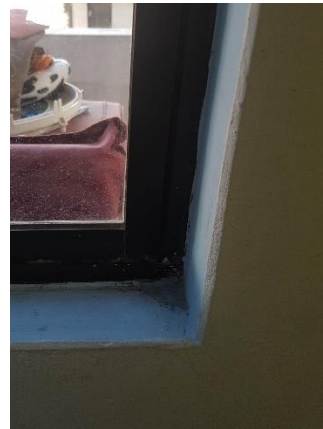
Imagen 37, 38, 39, 40: Defectos en la fabricación y ensamble en ventanas con marcos de aluminio Fuente: Propia
