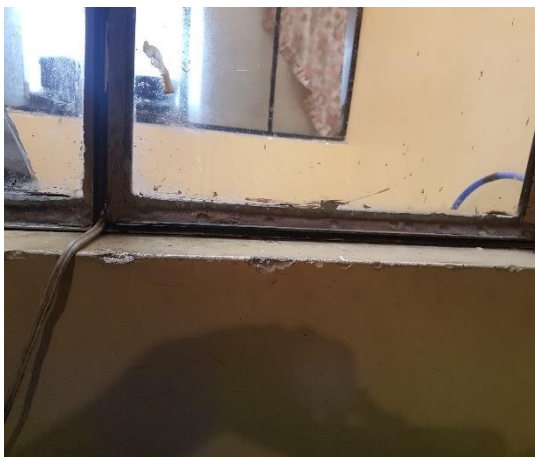
Imagen 33, 34, 35, 36: Defectos en la fabricación y ensamble en ventanas con marcos de acero Fuente: Propia
