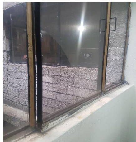
Imagen 33, 34, 35, 36: Defectos en la fabricación y ensamble en ventanas con marcos de acero Fuente: Propia
