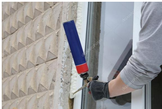
Imagen 54: Relleno de juntas con espuma aislante Fuente: Google
