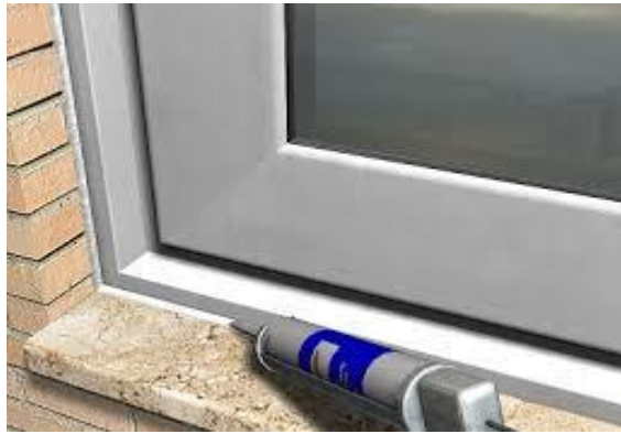
Imagen 55: Sellado de juntas con Silicona Fuente: Google
