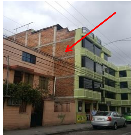
Imagen 18: Paredes de ladrillo macizo Fuente: Propia
