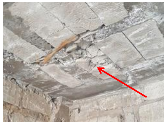
Imagen 28: Bloques triturados en fundición Fuente: Propia
