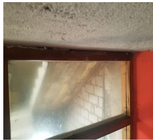
Imagen 43, 44, 45, 46, 47, 48: Defectos en la fabricación y ensamble en ventanas con marcos de Madera Fuente: Propia
