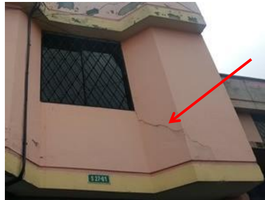
Imagen 22: Fisuramiento de pared Fuente: Propia
