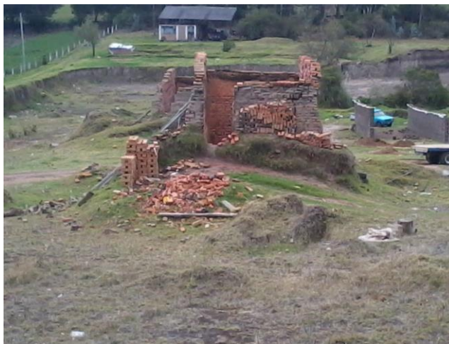
Gráfico 5.1: Ladrillera en Cállate – Pillaro
