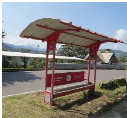
Figura 87 Parada de transporte Fuente: Elaboración propia, 2022
