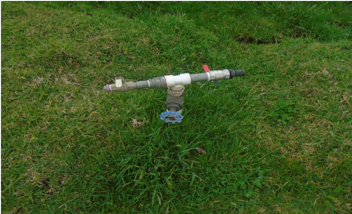
Fotografía 14: Evidencia de algunos arreglos e instalación del agua de riego
