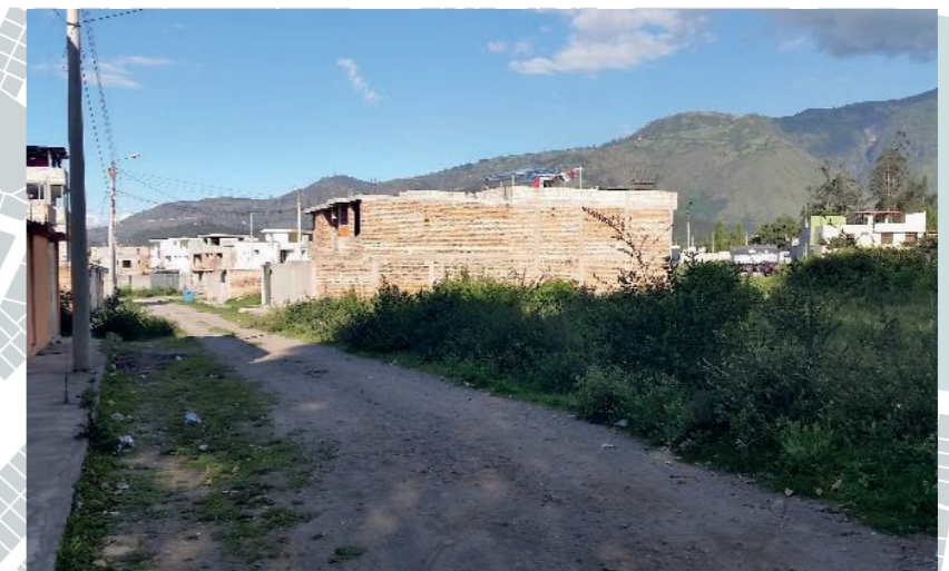
Fotografía 09: Estado de consolidación alrededor de Yuyucocha. (Flores, 2015)
